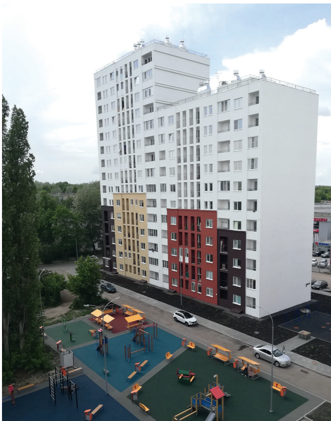
Пензенская область, город Пенза. Строительство дома осуществлялось в рамках программы переселения 2019-2025 годов
