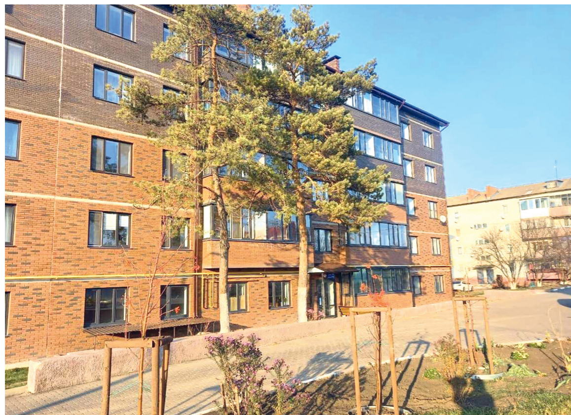
Белгородская область, Яковлевский район, поселок Яковлево. В доме приобретены квартиры в рамках программы переселения 2019-2025 годов
