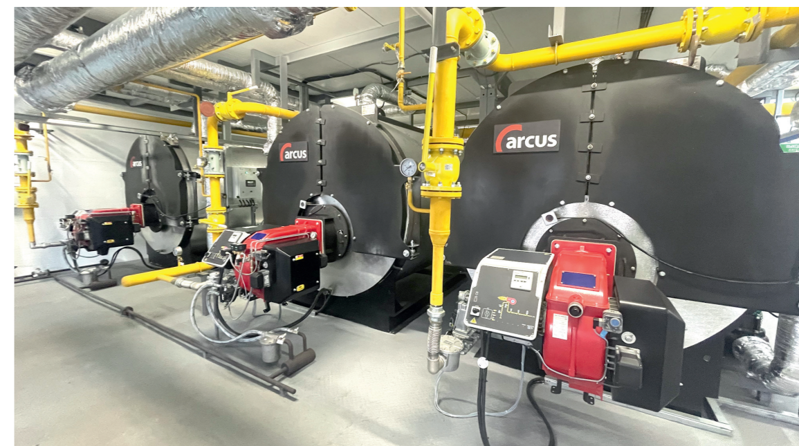
Томская область, Асиновское городское поселение. Строительство 9-ти модульных газовых котельных общей мощностью 42,8 МВт взамен угольных котельных
