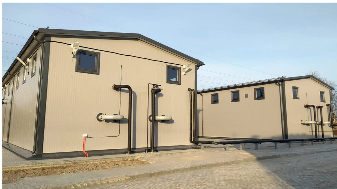
Калининградская область, Гурьевский район. Реконструкция очистных сооружений хозяйственно-бытовых сточных вод производительностью 3 тыс. м 3 /сут.
