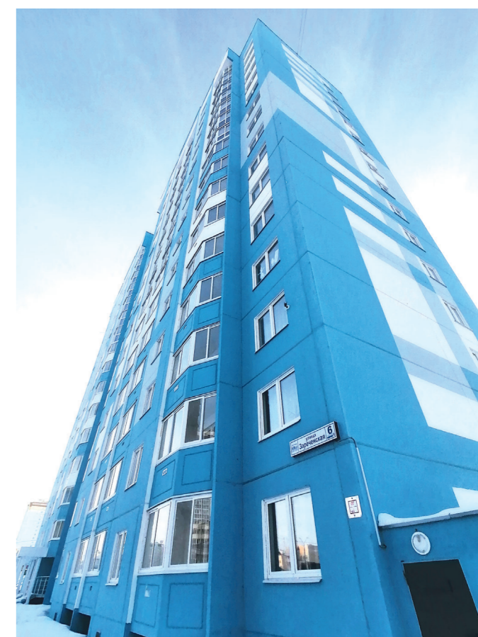
Орловская область, город Орел. В доме приобретены квартиры в рамках программы переселения 2019-2025 годов
