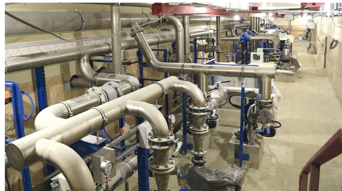
Свердловская область, Нижнесергинский район. Строительство очистных сооружений хозяйственно-бытовых сточных вод производительностью 3 тыс. м 3 /сут., в том числе строительство новой канализационной насосной станции перекачки стоков на очистные сооружения
