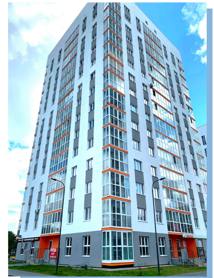
Тюменская область, город Тюмень. В доме приобретены квартиры в рамках программ переселения этапов 2019–2020 и 2020–2021 годов
