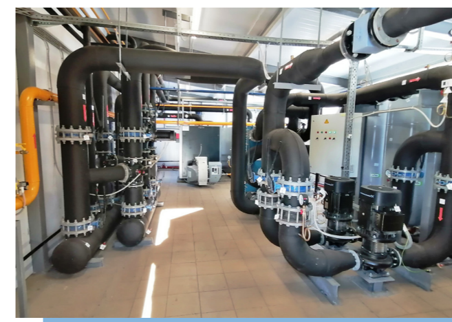
Владимирская область, Суздальский район. Реконструкция газовой котельной мощностью 3 Гкал/час
