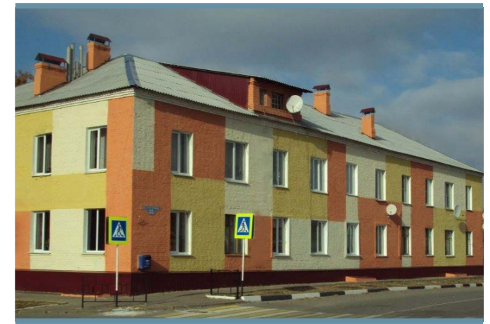
Белгородская область, город Новый Оскол. Многоквартирный дом после проведения капитального ремонта
