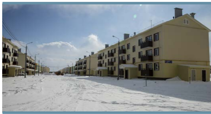
Сахалинская область, село Дальнее. Дома построены для переселения граждан из аварийного жилья
