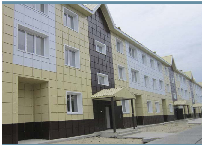
Ханты-Мансийский автономный округ, город Когалым. Дом построен для переселения граждан из аварийного жилья
