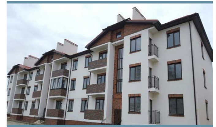
Краснодарский край, поселок городского типа Афипский. Дом построен для переселения граждан из аварийного жилья
