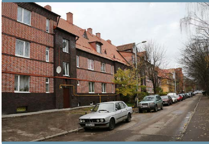
Калининградская область, город Калининград. Многоквартирный дом после проведения капитального ремонта
