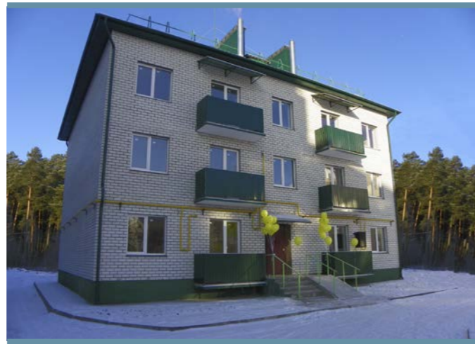
Новосибирская область, город Барабинск. Дом построен для переселения граждан из аварийного жилья
