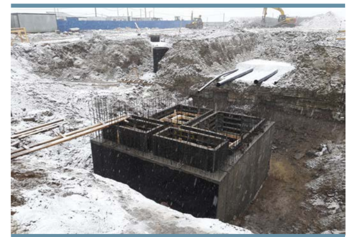
Ленинградская область, сельское поселение Федоровское. Строительство главной насосной станции
