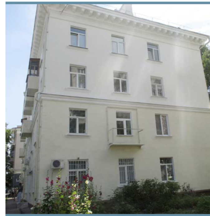
Республика Башкортостан, город Уфа. Многоквартирный дом после проведения капитального ремонта
