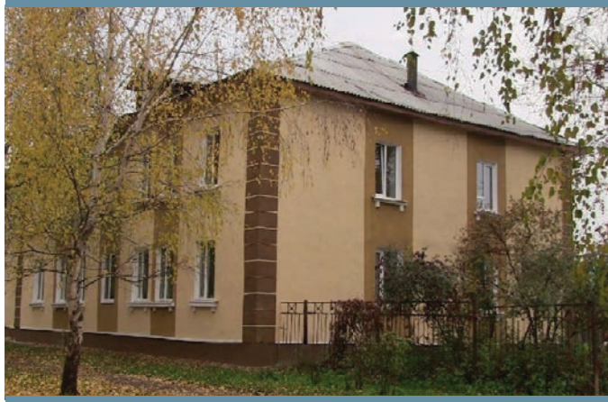
Республика Башкортостан, город Салават. Многоквартирный дом после проведения капитального ремонта
