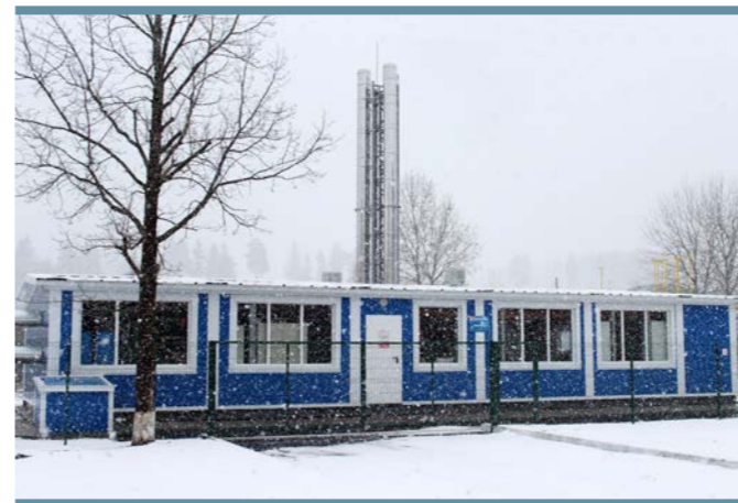
Владимирская область, город Киржач. Блочно-модульная котельная мощностью 7,5 МВт
