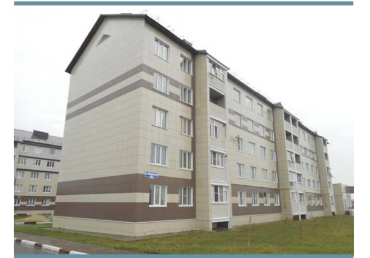
Тамбовская область, город Тамбов. Дом, в котором приобретены квартиры для переселения граждан из аварийного жилья
