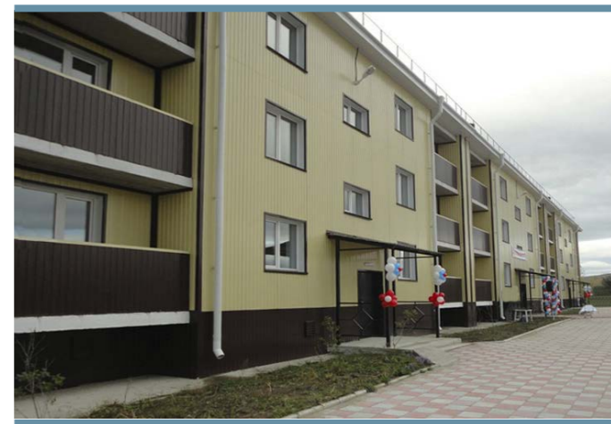
Красноярский край, село Тель. Дом построен для переселения граждан из аварийного жилья
