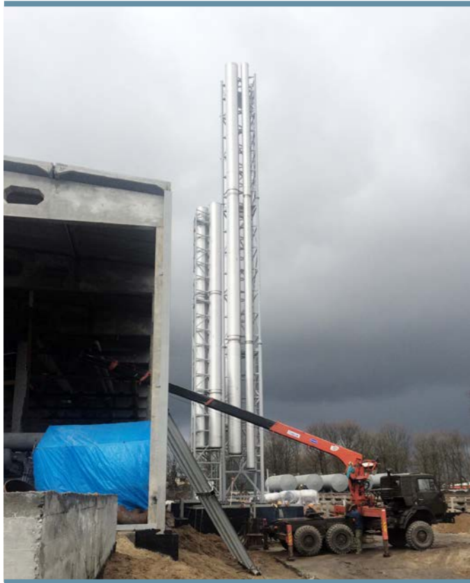
Калининградская область, город Советск. Строительство котельной мощностью 80 МВт
