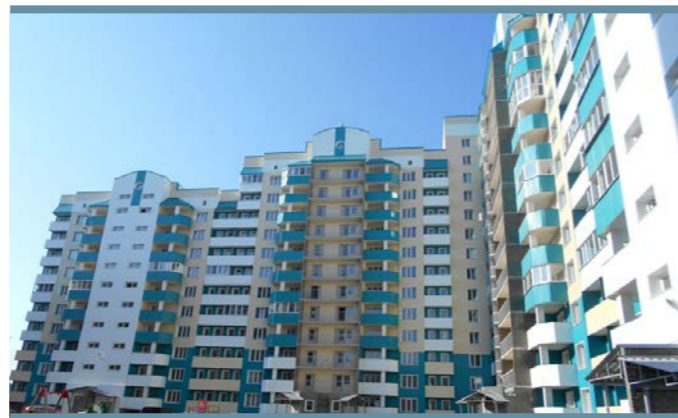
Алтайский край, город Барнаул. Дом построен для переселения граждан из аварийного жилья
