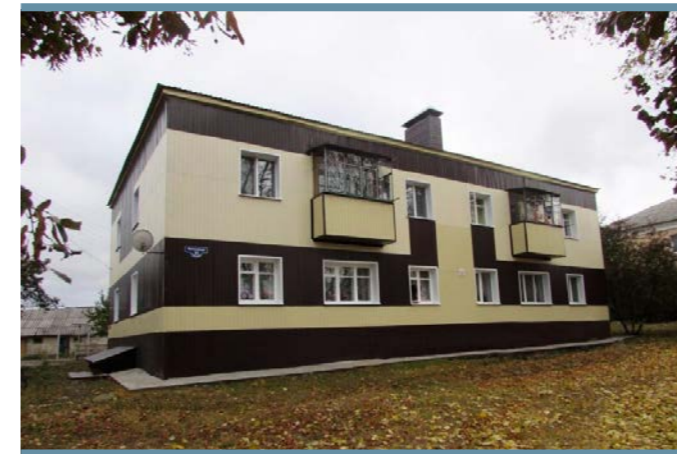
Белгородская область, поселок Ракитное. Многоквартирный дом после проведения капитального ремонта
