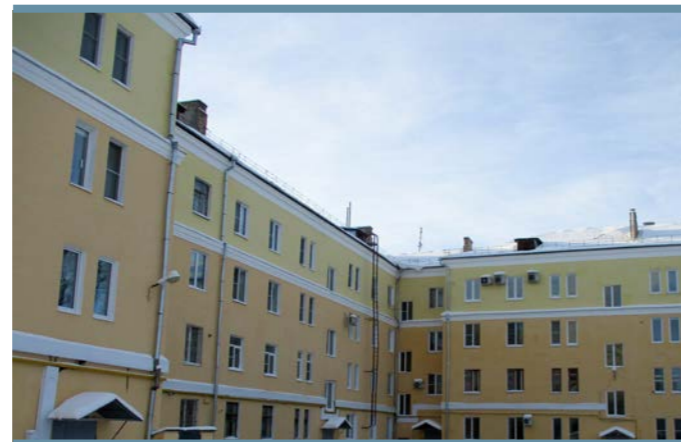
Владимирская область, город Ковров. Многоквартирный дом после проведения капитального ремонта
