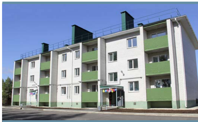
Брянская область, поселок Дубровка. Дом построен для переселения граждан из аварийного жилья
