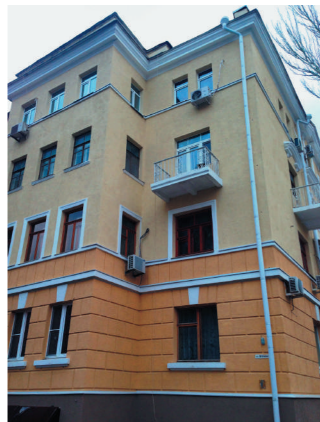
Ростовская область, город Ростов-на-Дону. Многоквартирный дом после проведения капитального ремонта
