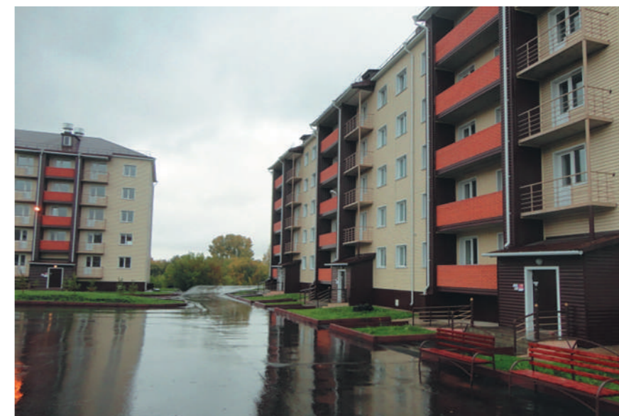
Кемеровская область, город Киселевск. Дом построен для переселения граждан из аварийного жилья
