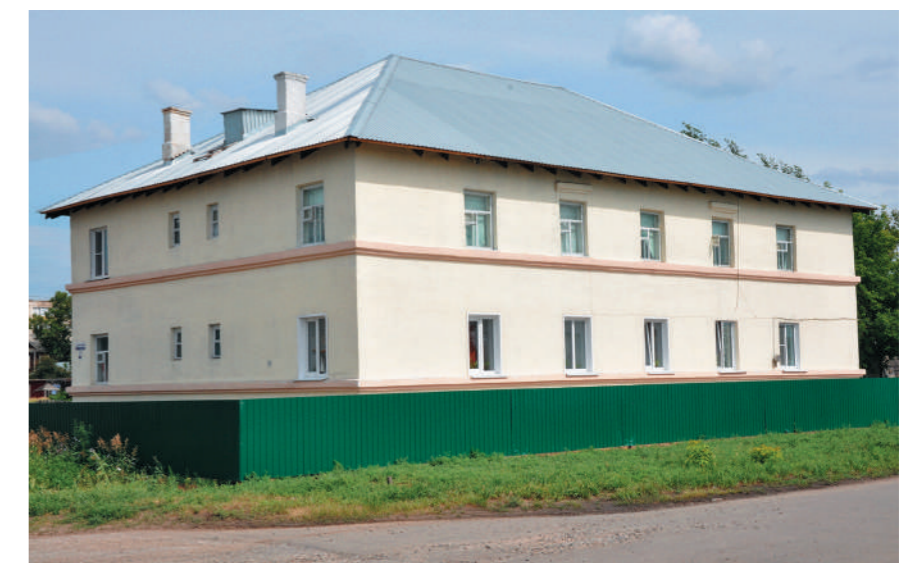
Алтайский край, село Кулунда. Многоквартирный дом после проведения капитального ремонта
