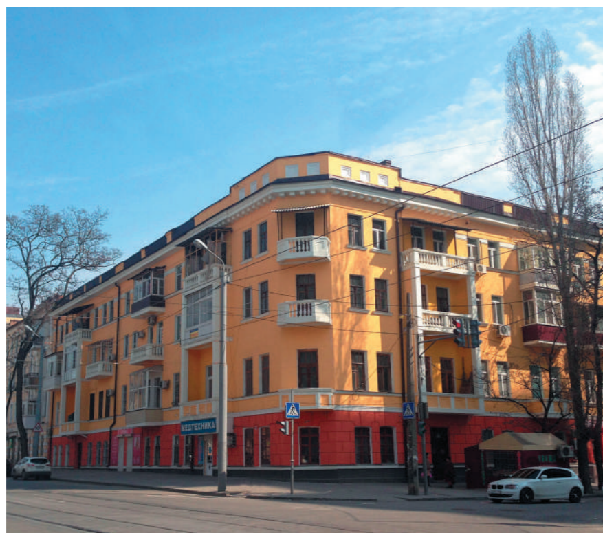
Ростовская область, город Ростов-на-Дону. Многоквартирный дом после проведения капитального ремонта
