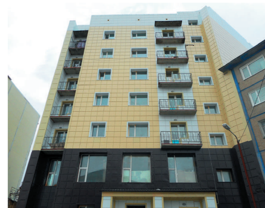
Магаданская область, город Магадан. Многоквартирный дом после проведения капитального ремонта
