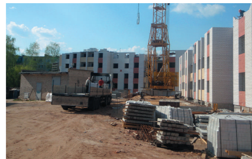
Брянская область. Строящийся дом в городе Клинцы. Строящийся многоквартирный дом по программе переселения граждан из аварийного жилья
