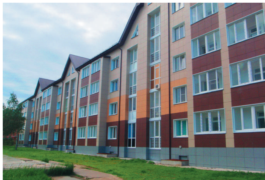
Ханты-Мансийский автономный округ – Югра, город Мегион. Дом построен для переселения граждан из аварийного жилья
