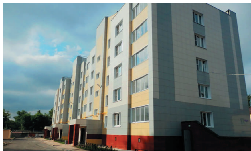
Липецкая область, город Липецк. Дом построен для переселения граждан из аварийного жилья
