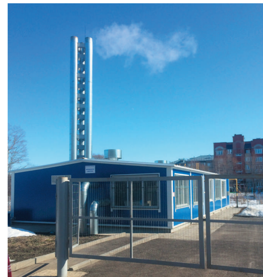
Владимирская область, город Юрьев-Польский. Блочно-модульная котельная мощностью 8 МВт
