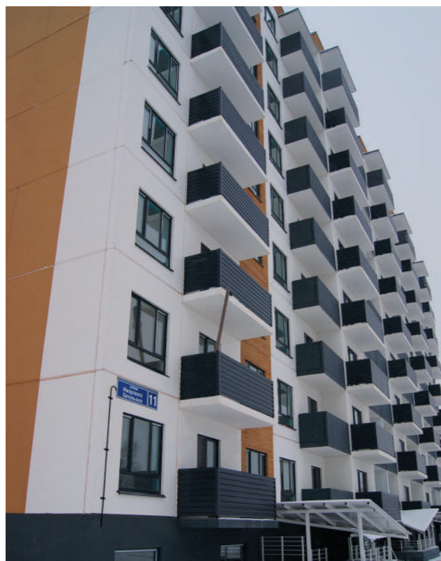
Псковская область, город Псков. Дом, в котором приобретены квартиры для переселения граждан из аварийного жилья
