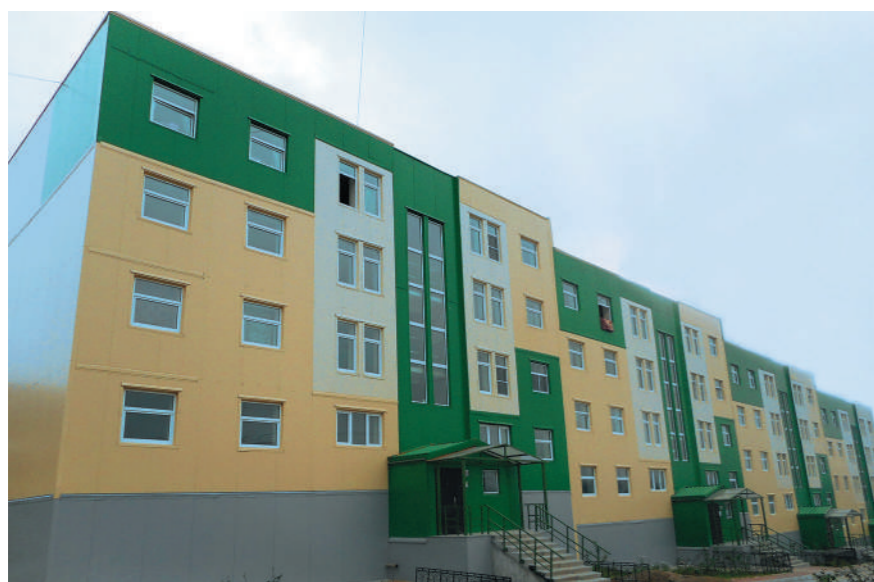
Магаданская область, город Магадан. Многоквартирный дом после проведения капитального ремонта
