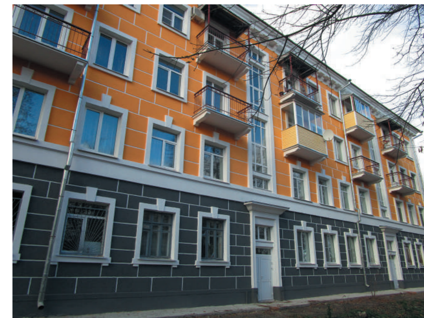
Владимирская область, город Владимир. Многоквартирный дом после проведения капитального ремонта
