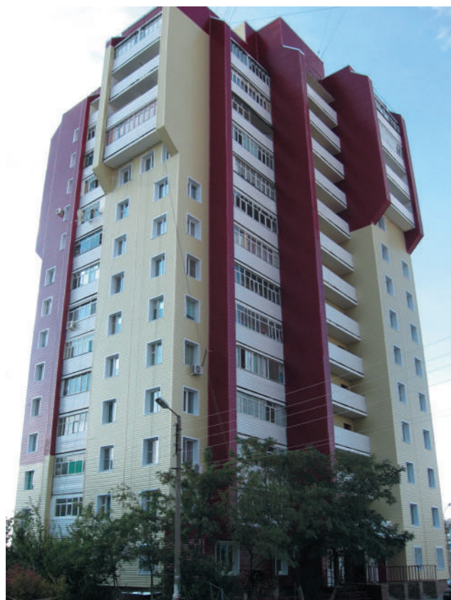
Волгоградская область, город Волжский. Многоквартирный дом после проведения капитального ремонта
