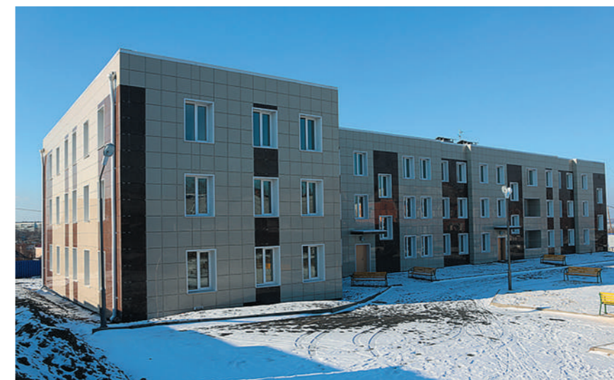
Приморский край, город Владивосток. Дом построен для переселения граждан из аварийного жилья
