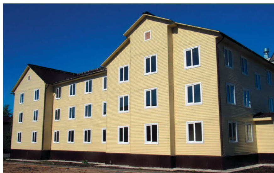
Архангельская область, город Онега. Дом построен для переселения граждан из аварийного жилья
