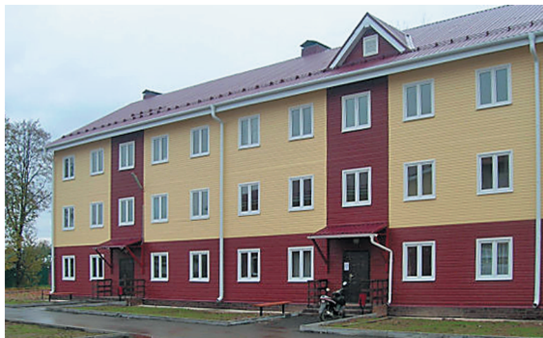
Ивановская область, Родниковское городское поселение, микрорайон Южный. Многоквартирный дом построен для переселения граждан из аварийного жилья
