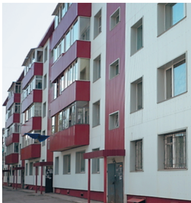
Камчатский край, город Петропавловск-Камчатский. Многоквартирный дом после проведения капитального ремонта
