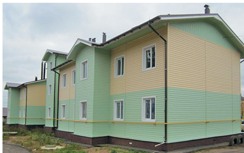
Ивановская область, Новогоркинское сельское поселение. Дом построен для переселения граждан из аварийного жилья
