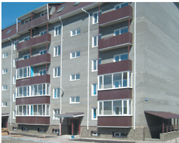
Республика Алтай. Дом в городе Горно-Алтайске построен по программе переселения граждан из аварийного жилья
