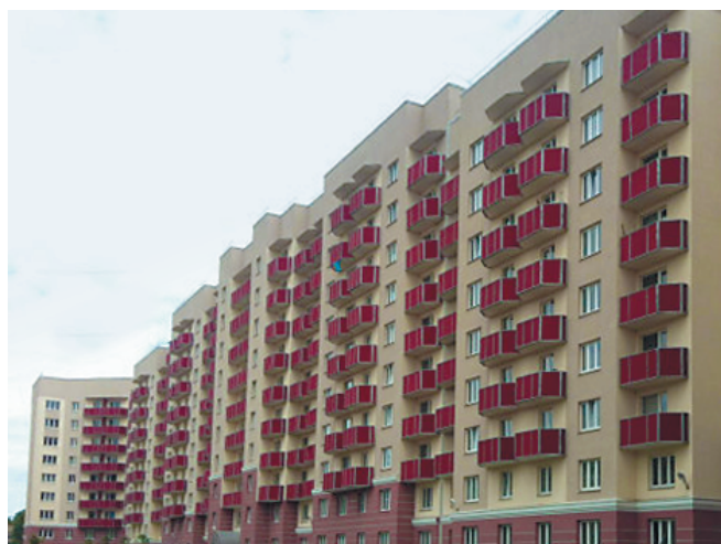
Город федерального значения Санкт-Петербург. В данном доме в рамках реализации программы по переселению граждан из аварийного жилья приобретено 103 жилых помещения
