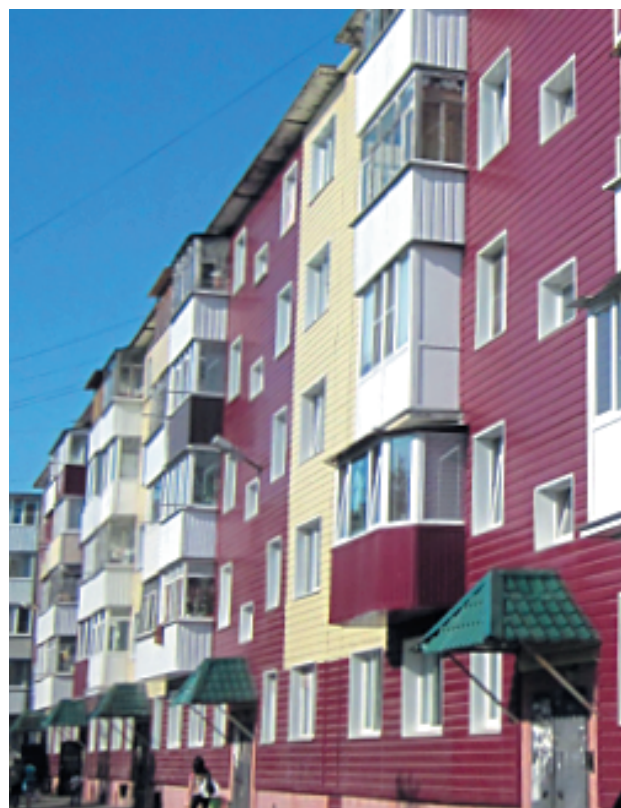
Камчатский край, город Петропавловск-Камчатский. Многоквартирный дом после проведения капитального ремонта
