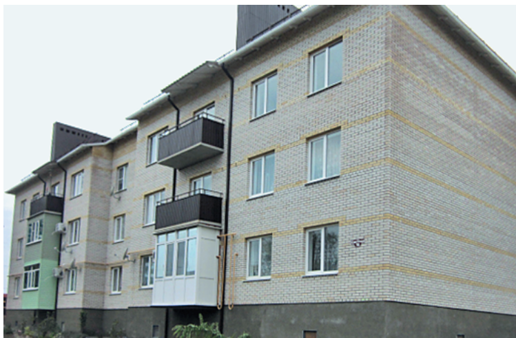
Ростовская область, город Каменск-Шахтинский. Новый многоквартирный дом, построенный для переселения граждан из аварийного жилья
