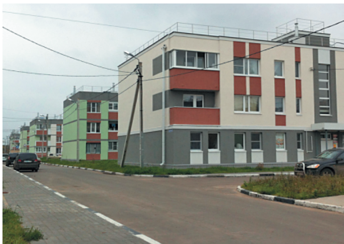
Нижегородская область. Жилой поселок в малоэтажном микрорайоне в Нижнем Новгороде построен для переселения граждан из аварийного жилья
