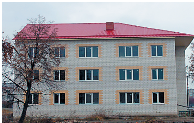
Курганская область. Строящийся многоквартирный дом по программе переселения граждан из аварийного жилья в городе Катайске
