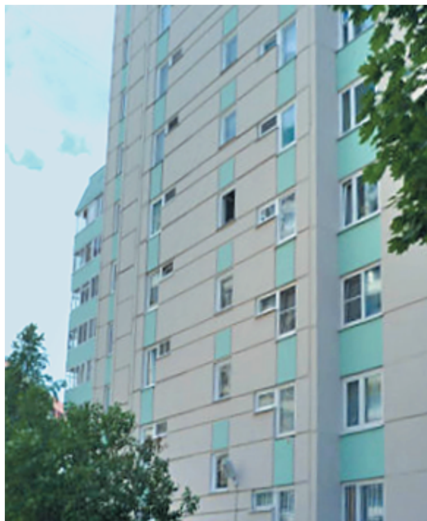
Город Санкт-Петербург. Многоквартирный дом после проведения капитального ремонта
