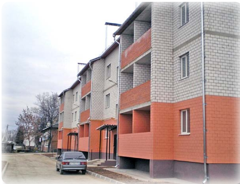
Рисунок 25. Калужская область, город Киров. Многоквартирный дом, построенный для переселения граждан из аварийного жилья
