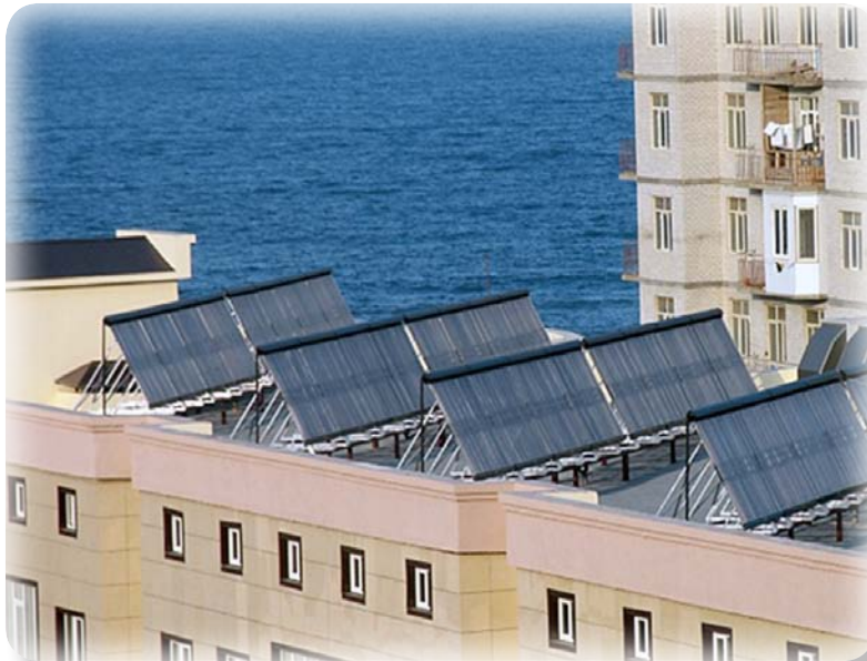
Рисунок 21. Республика Дагестан, город Каспийск. Солнечные коллекторы в энергоэффективном доме
