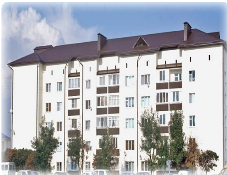
Рисунок 1. Кабардино-Балкарская Республика, город Чегем. Многоквартирный дом после проведения капитального ремонта
