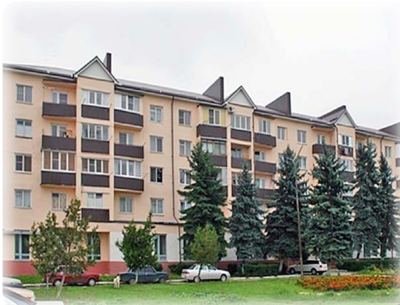
Рисунок 17. Кабардино-Балкарская Республика, город Нарткала. Многоквартирный дом после проведения капитального ремонта
