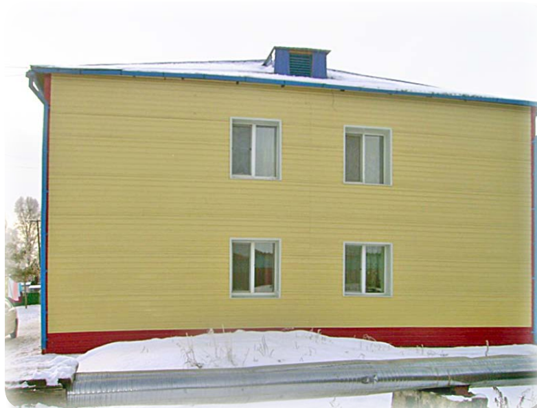
Рисунок 13. Амурская область, поселок городского типа Екатеринославка. Многоквартирный дом после проведения капитального ремонта
