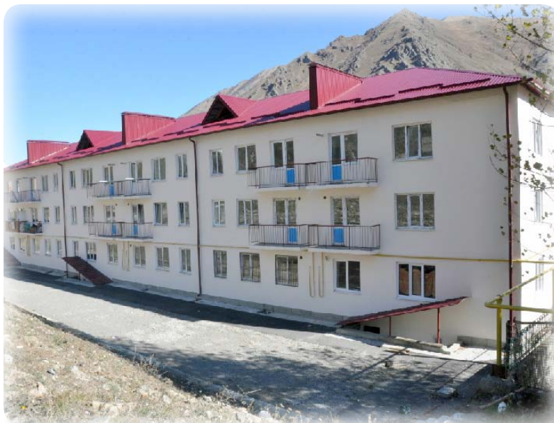
Рисунок 27. Кабардино-Балкарская Республика, город Тырныауз. Многоквартирный дом, построенный для переселения граждан из аварийного жилья
