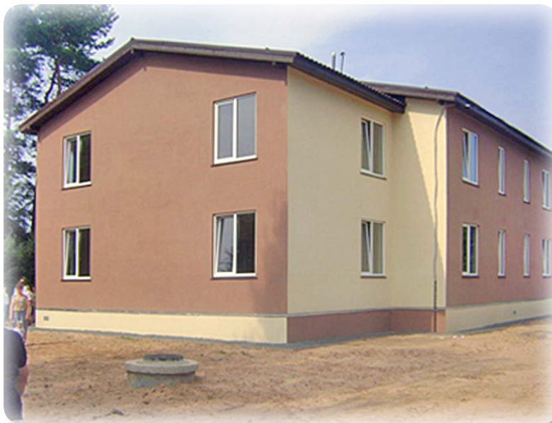
Рисунок 31. Вологодская область, Вытегорский район, поселок Белоусово. Многоквартирный дом, построенный для переселения граждан из аварийного жилья
