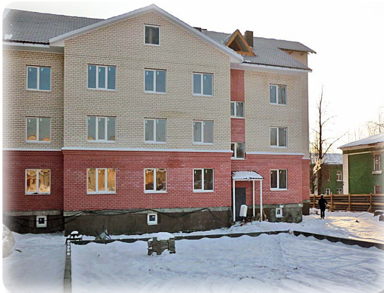
Рисунок 20. Свердловская область, город Полевский. Многоквартирный дом, построенный для переселения граждан из аварийного жилья
