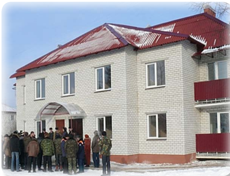
Рисунок 23. Брянская область, поселок Клетня. Многоквартирный дом, построенный для переселения граждан из аварийного жилья
