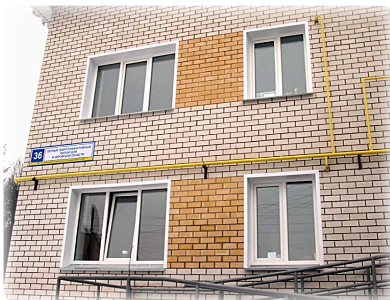
Рисунок 44. Кировская область, поселок Юбилейный. Энергоэффективный дом
