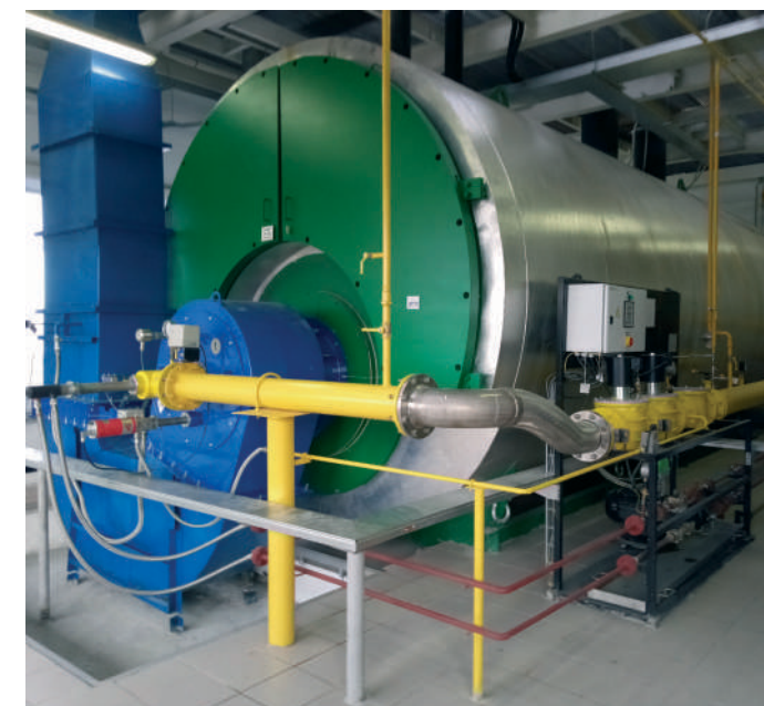
Челябинская область, город Троицк. Оборудование газовой котельной мощностью 120 МВт
