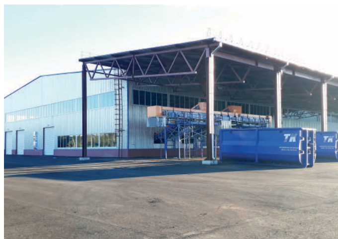
Воронежская область, Семилукский муниципальный район. Мусоросортировочный завод мощностью 440 тыс. тонн/год
