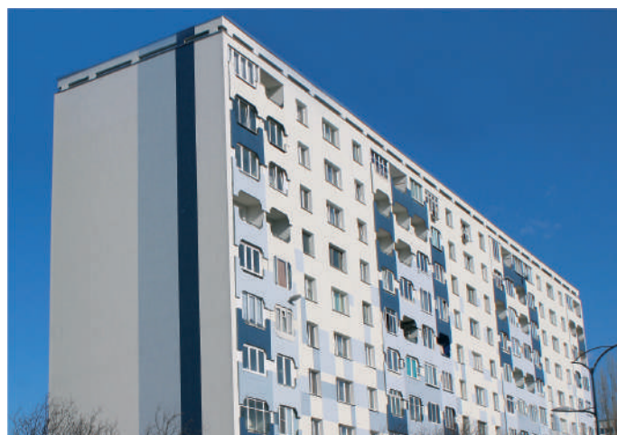
Калининградская область, город Калининград. Утепленный фасад дома в рамках проведения энергоэффективного капитального ремонта
