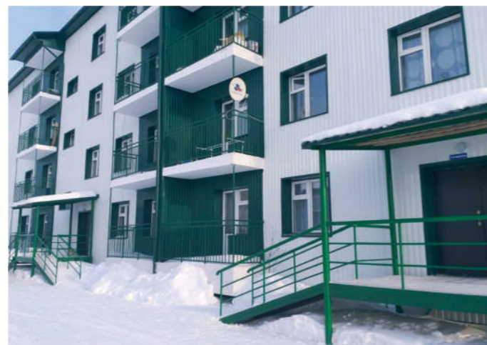
Республика Саха (Якутия), город Ленск. Дом построен для переселения граждан из аварийного жилья
