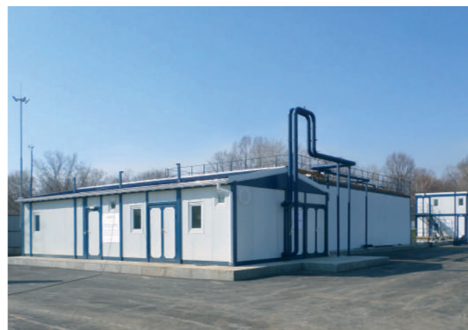
Хабаровский край, рабочий поселок Переяславка. Очистные сооружения производительностью 1000 м 3 /сутки
