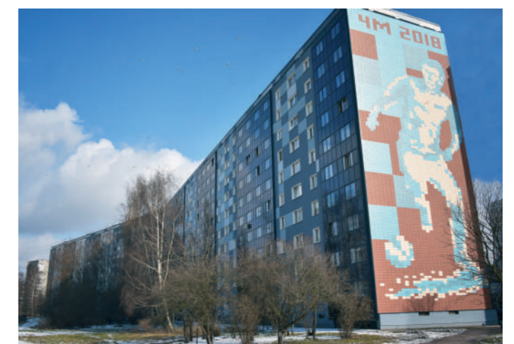
Калининградская область, город Калининград. Утепленный фасад дома в рамках проведения энергоэффективного капитального ремонта
