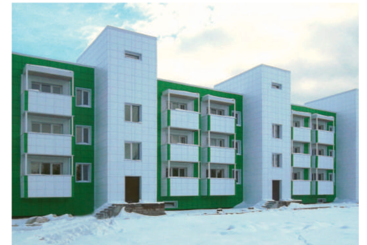
Республика Саха (Якутия), поселок Серебряный Бор. Дом построен для переселения граждан из аварийного жилья
