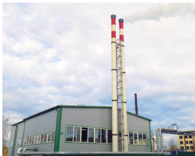
Смоленская область, Угранское сельское поселение. Котельная мощностью 3 МВт
