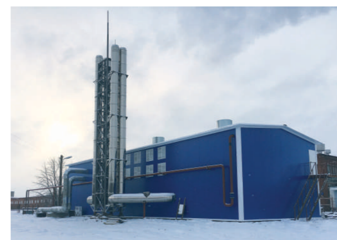
Владимирская область, город Суздаль. Блочно-модульная котельная мощностью 16 МВт
