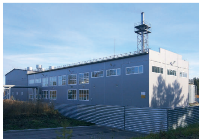
Кемеровская область, Беловский городской округ. Угольная котельная мощностью 30 МВт
