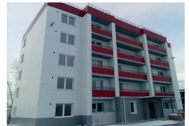
Иркутская область, город Братск. Дом построен для переселения граждан из аварийного жилья
