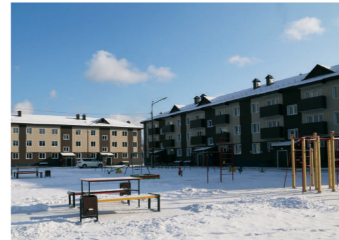
Сахалинская область, поселок городского типа Смирных. Дома построены для переселения граждан из аварийного жилья
