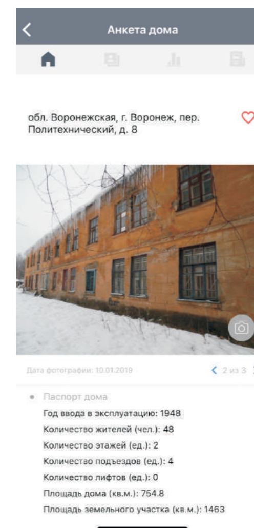
Рисунок 4. Просмотр анкеты аварийного дома в мобильном приложении «Реформа ЖКХ»
